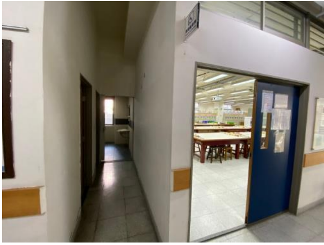
工程大樓-無障礙廁所
